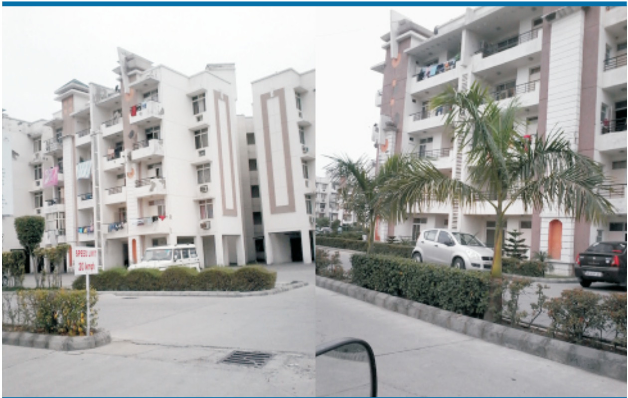
CONSTRUCTION OF OMAXE RIVIERA RUDRAPUR UTTARAKHAND FOR OMAXE LTD.
